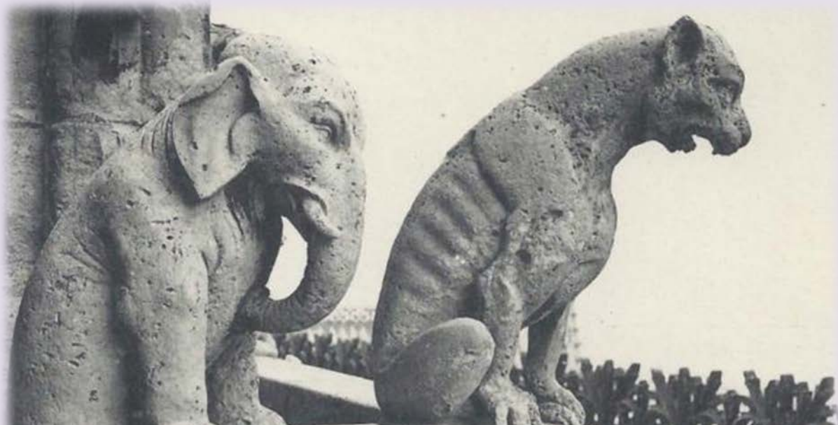
I gargoyles di Notre-Dame di Parigi altro non sono che doccioni o gocciolatoi per far defluire l'acqua piovana - Fonte: fotogramma da Youtube
