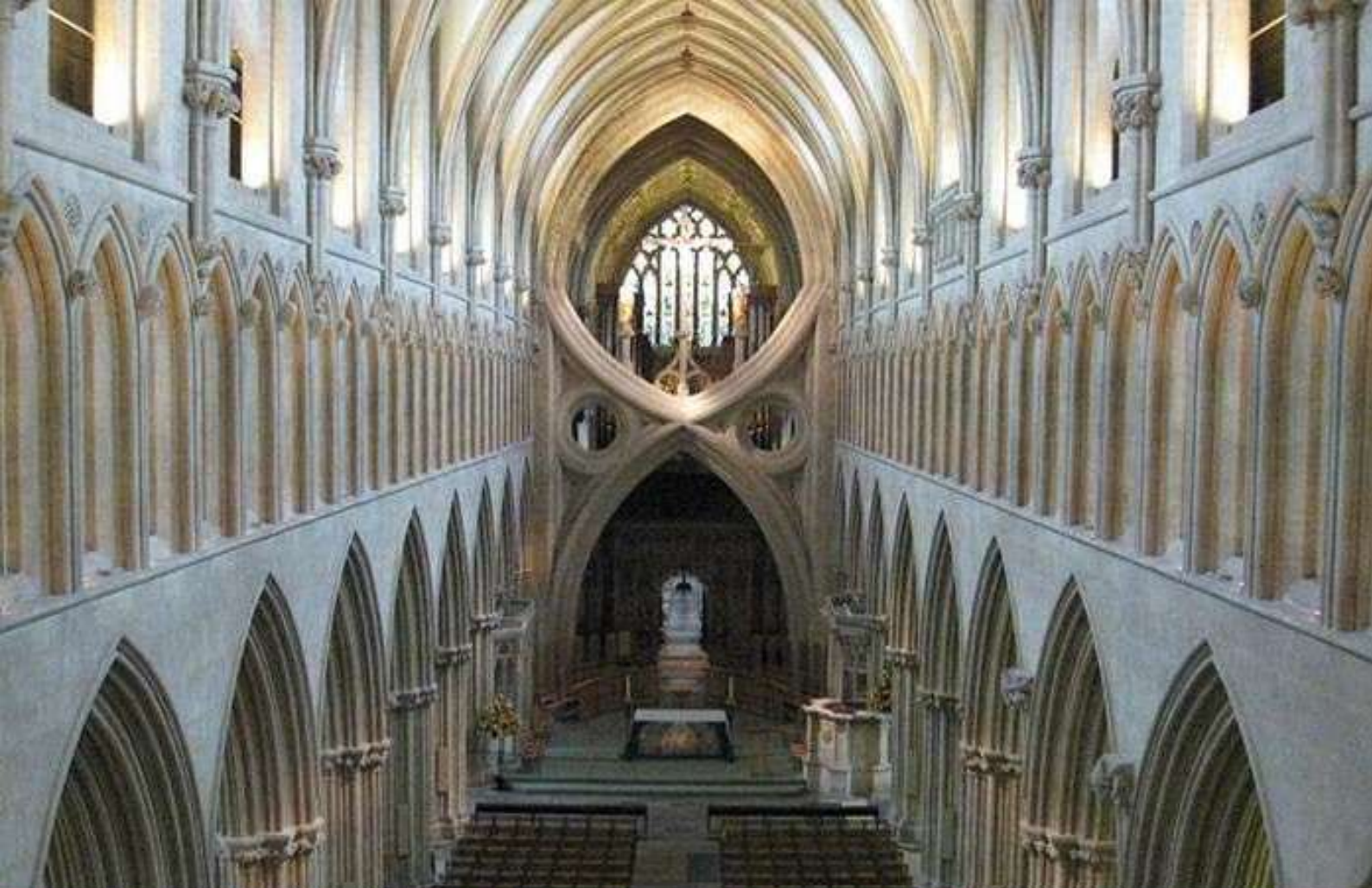
In alto, la navata della cattedrale con gli archi a forbice - Fonte: Goticomania Si nota bene lo spessore del muro e la presenza, nelle arcate a sesto acuto della navata, di modanature arrotondate, che manifestano lo spessore del muro, elemento tipico del Gotico inglese
