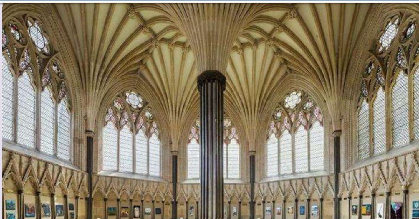
Volta “a ventaglio” della sala capitolare della cattedrale di Wells Fonte: Goticomania Le sale capitolari a pianta centrale connotano l’architettura medievale inglese, anche se seguono due linee opposte: o volutamente ornate da tiercerons dipartiti dal pilastro centrale o pensate come “case di vetro”
