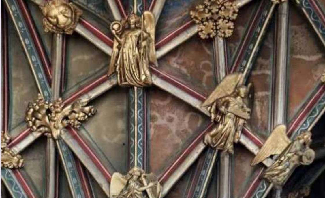
Dettagli della volta del presbiterio - Fonte: Video sul sito della Khan Academy
