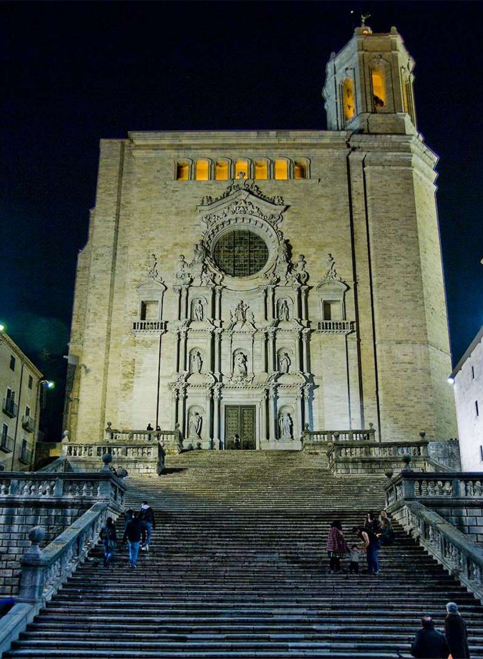
La facciata principale - Fonte: Wikipedia © SBA73CC BY-SA 2.0
