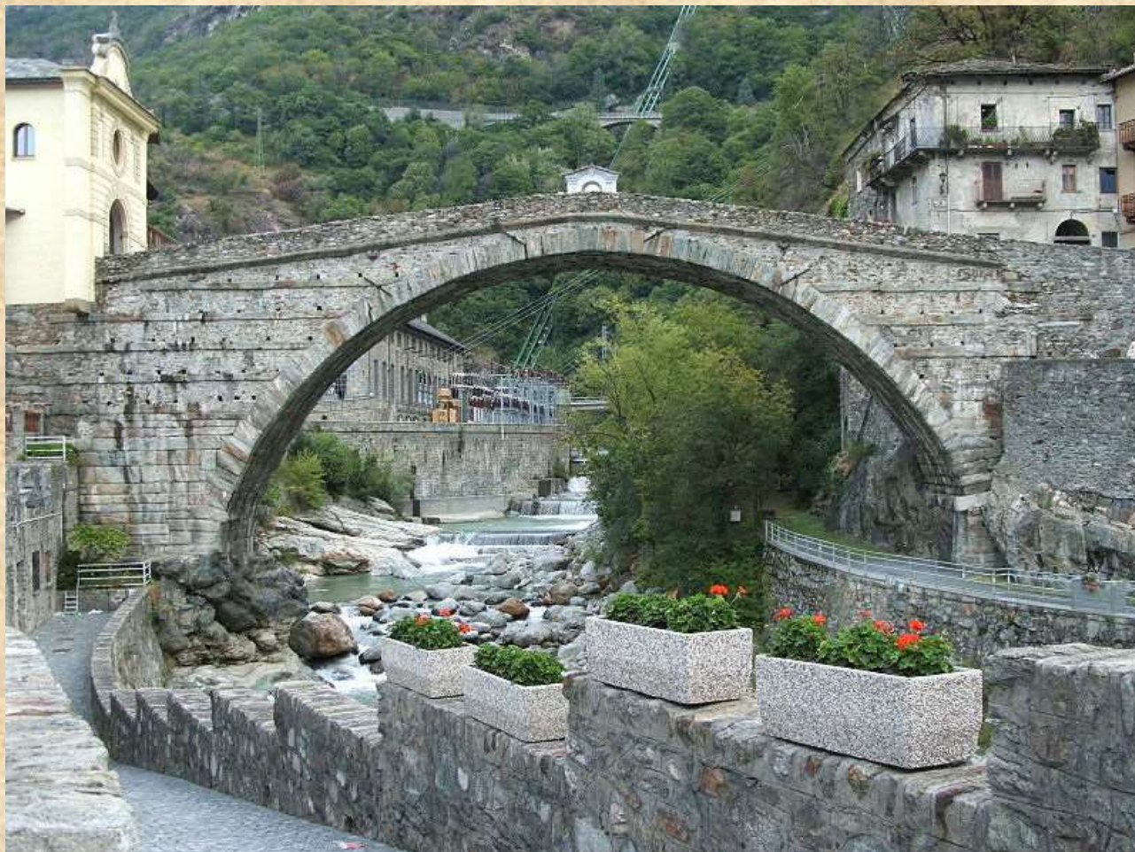
Il Comune di Pont-Saint-Martin (al confine tra Valle d'Aosta e Piemonte) prende il nome dall'omonimo ponte, di epoca romana (I sec. a.C.), alto 23 metri, lungo ben 31 metri , largo 6. Fu in uso fino al 1831, quando venne costruito un nuovo ponte sul torrente Lys
